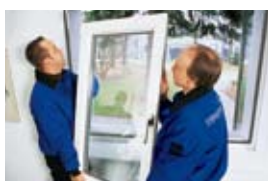
Montage – saubere Arbeit zum vereinbarten Termin
