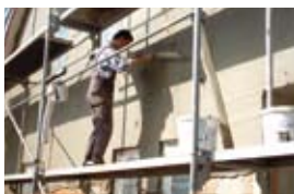
Montage – saubere Arbeit zum vereinbarten Termin
